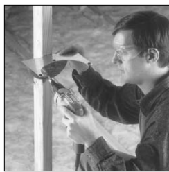
Fixer le support de montage (NB).
